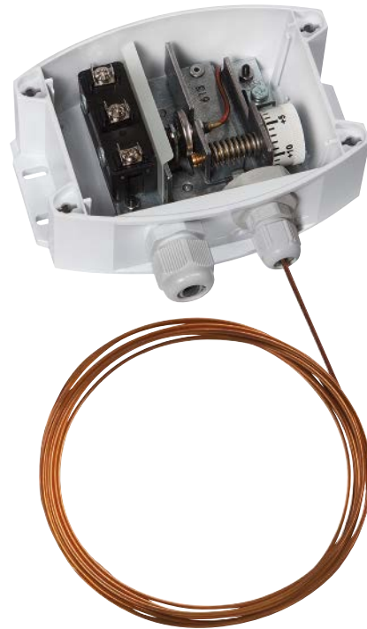
FST-xD TW = termostato (commutazione autonoma)
